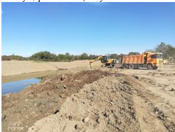
Рисунок 3.4.11. Ремонт дамбы обвалования в районе хутора Бережного Абинского городского поселения в октябре месяце 2018 году.
