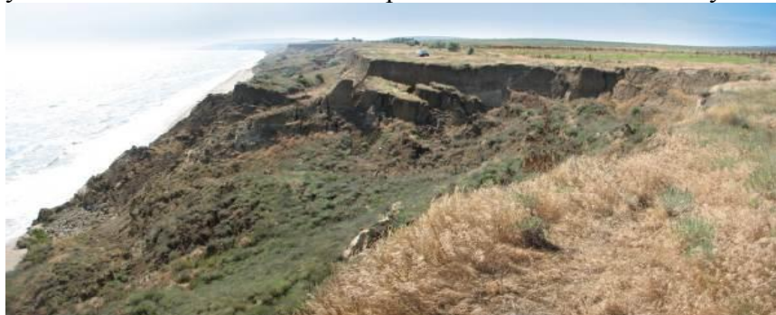
Рисунок 1.3.19 – Оползень в районе пос. Веселовка
