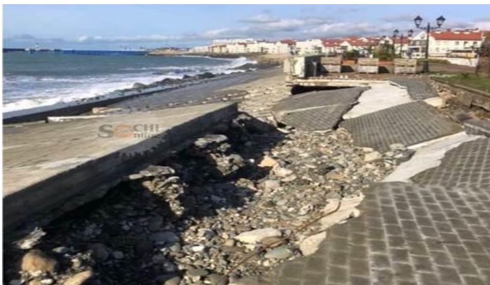
Рисунок 1.3.18 – Результат гидродинамического воздействия геоморфологических особенностей каньона Новый на набережную и конструкции берегоукрепления Олимпийского парка
