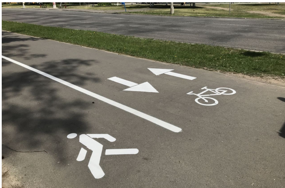
Рисунок 1 Пример разделения велосипедного и пешеходного потоков
