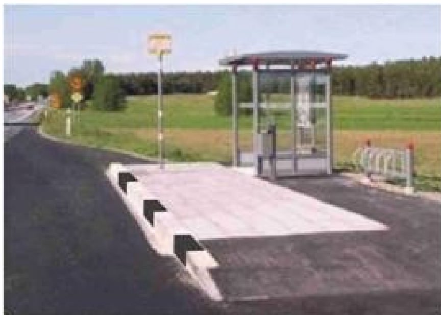
Рисунок 10 Пример организации пандуса на остановочном пункте
