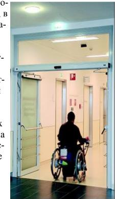
требуя замены дверей (монтируются на уже установленные), и питаются от бытовой электросети 220 вольт. Самая обычная распашная дверь может быть автоматизирована при помощи **автоматического привода**. Он устанавливается на механическую дверь как обычный дверной доводчик с наружной или внутренней стороны, включается в розетку - и дверь становится автоматиче-
