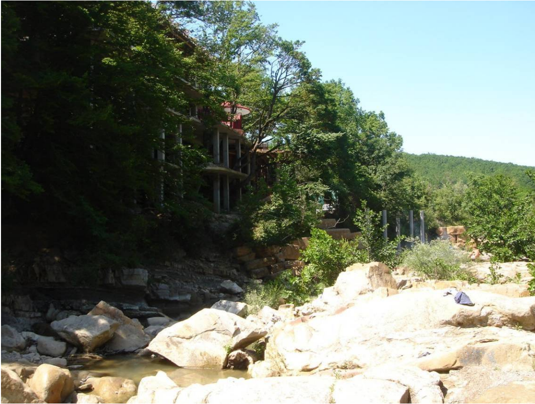
Строящийся спортивно-оздоровительный комплекс на левом берегу р. Убинка в ст. Убинской
